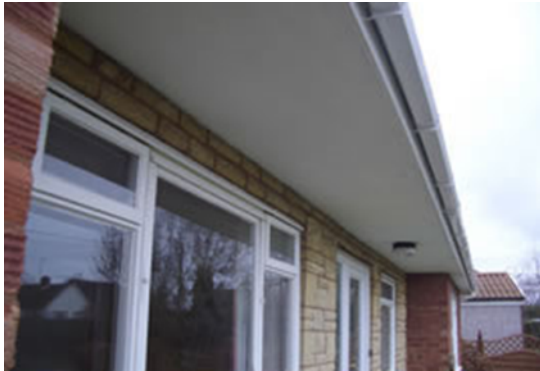
Asbestos soffit
